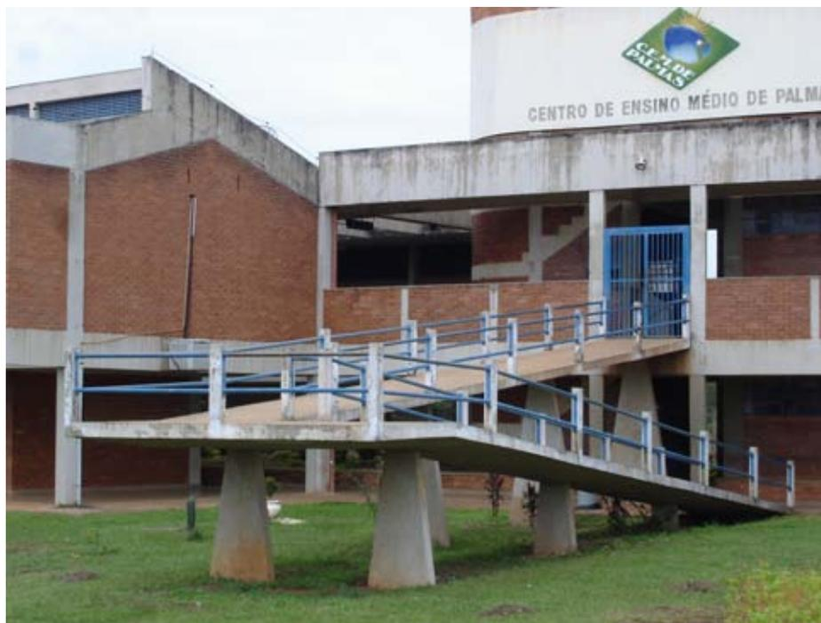
Foto 8: Exemplo de rampas de acesso a edifício escolar em Palmas. A declividade e o comprimento de cada lance da rampa devem respeitar a norma técnica.
